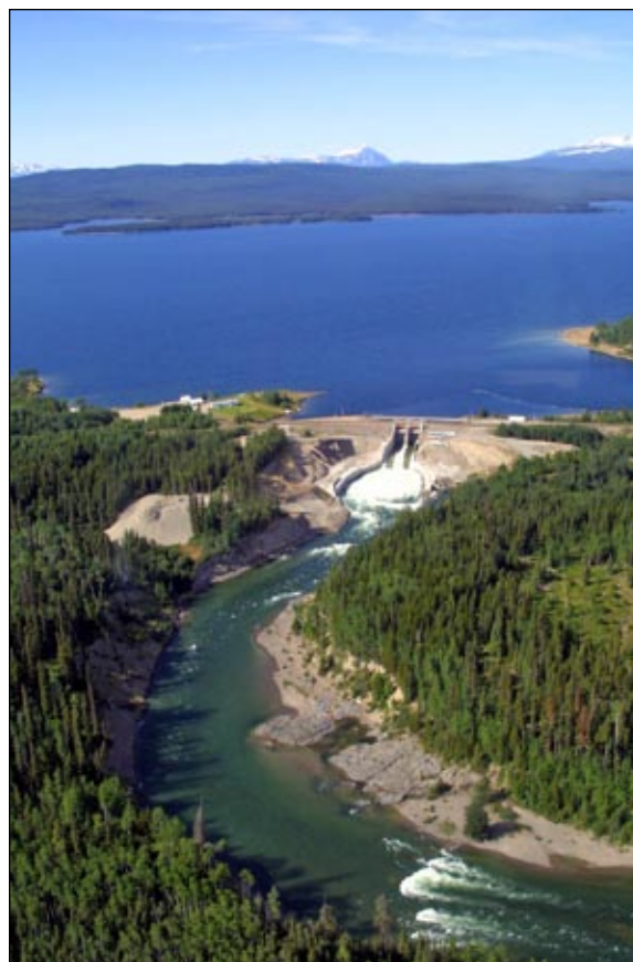
Skins Lake Spillway
